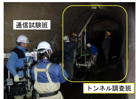
図-4 坑内通信試験状況
